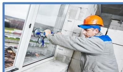
3. Con una ventosa se deberá levantar el vidrio e incorporarlo al buque primero en la parte inferior sobre las calzas anteriormente puestas y luego la parte superior con una inclinación.
