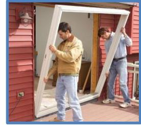
11. Las perforaciones para fijar el contramarco lateral y superior se hacen con una broca de 1/4 para concreto. Luego se retira el contramarco, se limpian los agujeros y se introduce el expander #7, que debe quedar completamente embutido en la pared.
