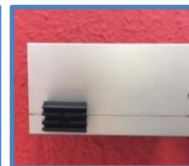
4. Posteriormente se atornillan los clips en los puntos marcados, para luego poner el marco con el cedazo en los clips.
