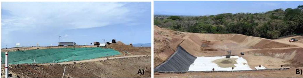
Figura 2. Costa Rica, INA: Unidad Regional Pacífico Central. Relleno Sanitario Tecnoambiente, controles ambientales. B) Celda activa con camiones depositando residuos. B) Construcción de la celda ocho, preparación del suelo, con geotextil y coberturas de tierra. Año 2025.
