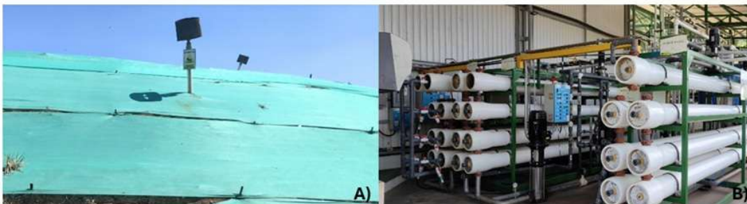
Figura 3. Costa Rica, INA: Unidad Regional Pacífico Central. Relleno Sanitario Tecnoambiente, controles ambientales. A) Evacuación de gases con chimeneas para la quema del metano y coberturas a la celda. B) tratamiento aguas residuales con sistema de micro y nanofiltración. Año 2025.
